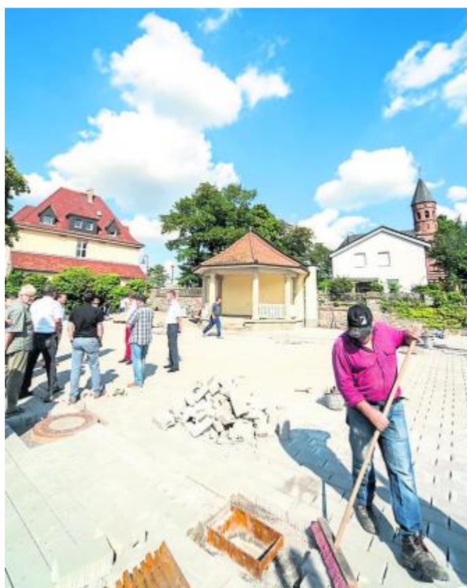
Nie wieder Schlammwüste: Die neue Pflasterung am Lorsch Pavillon ist bald fertiggestellt. Foto: Karl-Heinz Köppner
